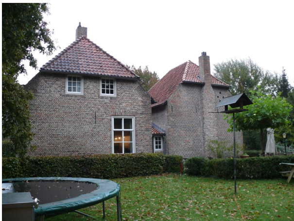
Afb. 7 Saneringslocatie Havenweg 10 voor aanvang van de werkzaamheden.
