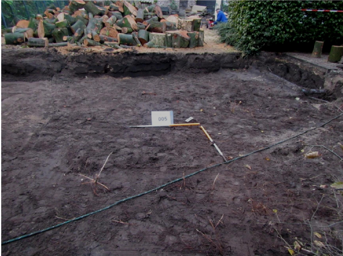
Afb. 8 Ontgraving aan voorzijde van het woonhuis Havenweg 10. Gezien naar het noordwesten.
