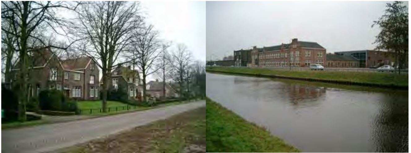
Industrieel complex en fabrikantenvilla's aan weerszijden van de Zuid-Willemsvaart (bron CHW 2006)
