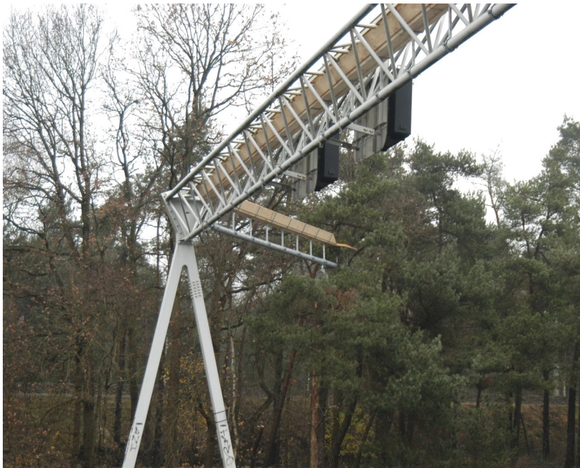
Foto: boommarterbrug over de A12 bij Driebergen (foto Rijkswaterstaat).
