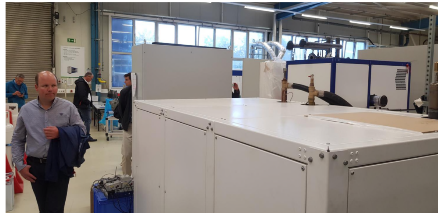
Bezoek aan een hoge temperatuur warmtepomp bij Viking in Remscheid: tot maximaal 165°C, temperatuursprong 50-60 °C.
