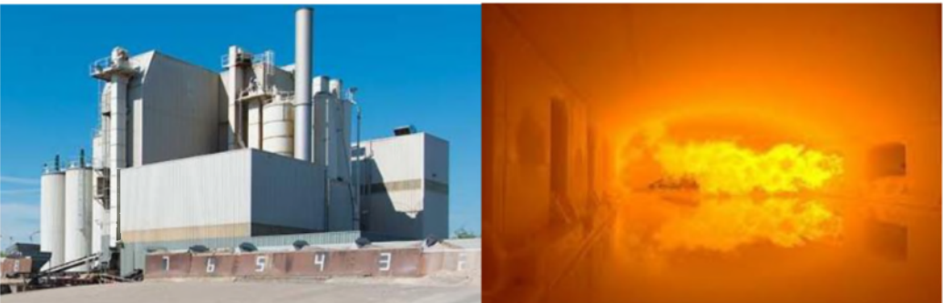
Asfaltfabriek 170 °C ( BAC) en Glasoven > 1000 °C (VNG)
