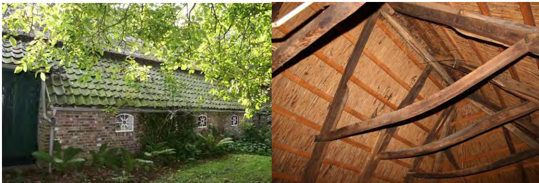
Afbeelding: voorgevel en kapconstructie Herendijk 12 te Lieshout
