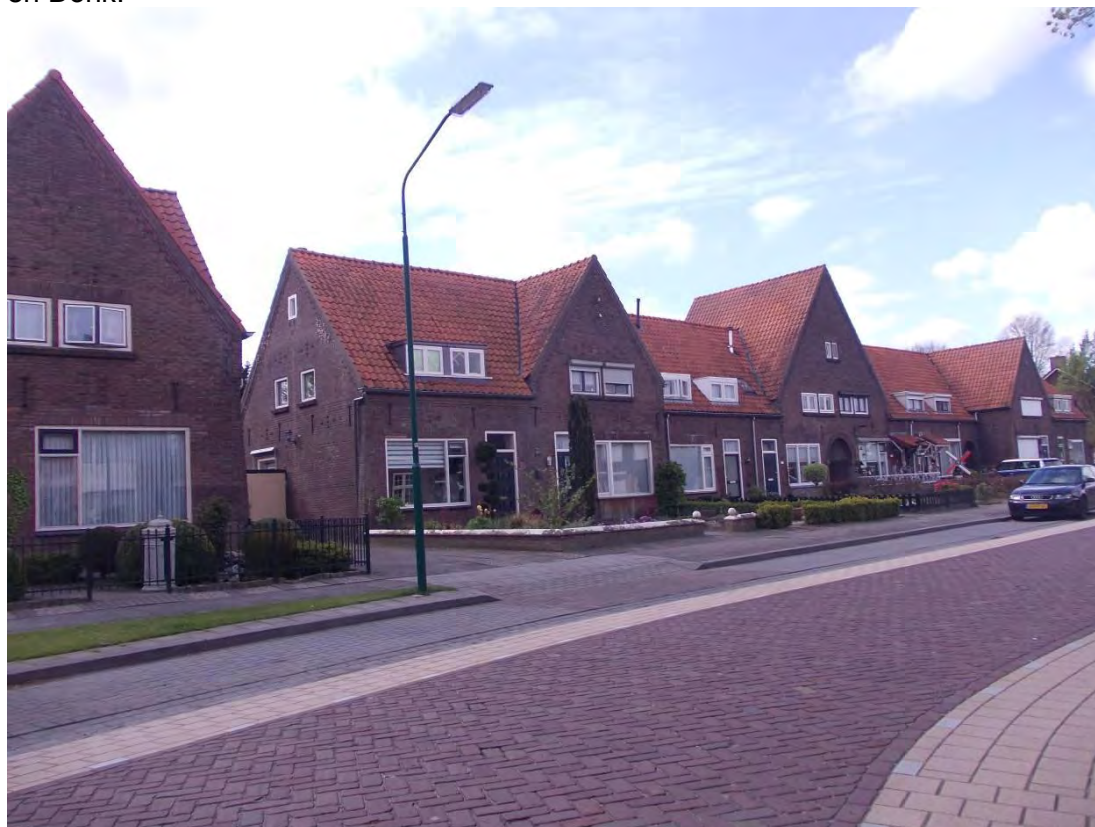
Afbeelding: Sociale woningbouw aan de Dr. Timmerslaan in Beek en Donk (april 2012)
