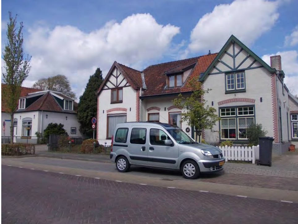
Afbeelding: arbeiderswoningen aan de Monseigneur Verhagenstraat (april 2012)
