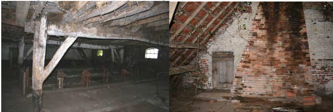
Afbeelding: grupstal met gebint en rechts de zolder met schouw en brandmuur.
