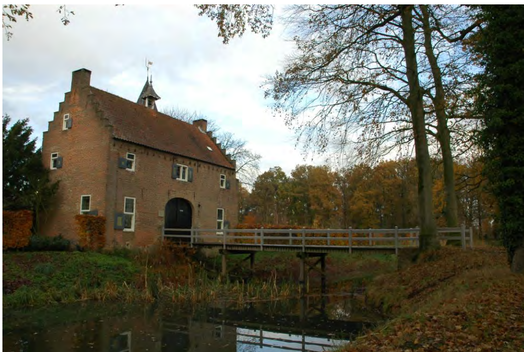
Afbeelding: Poortgebouw van Croy (oktober 2011)
