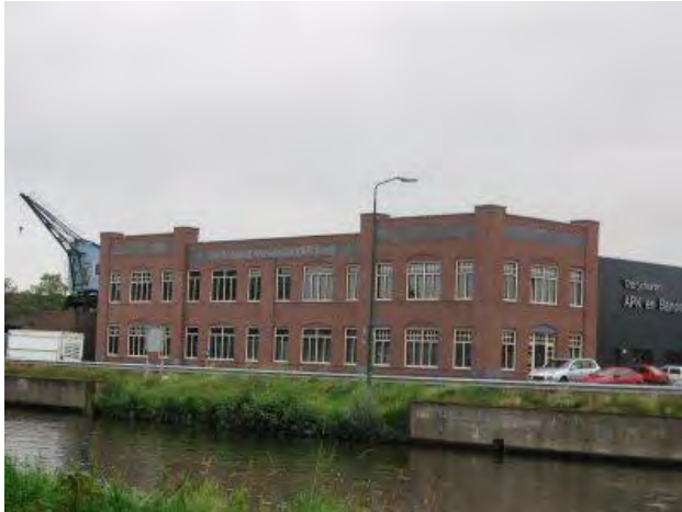
Afbeelding: kantoorgebouw van de draad- of klinknagelfabriek Van Thiel
